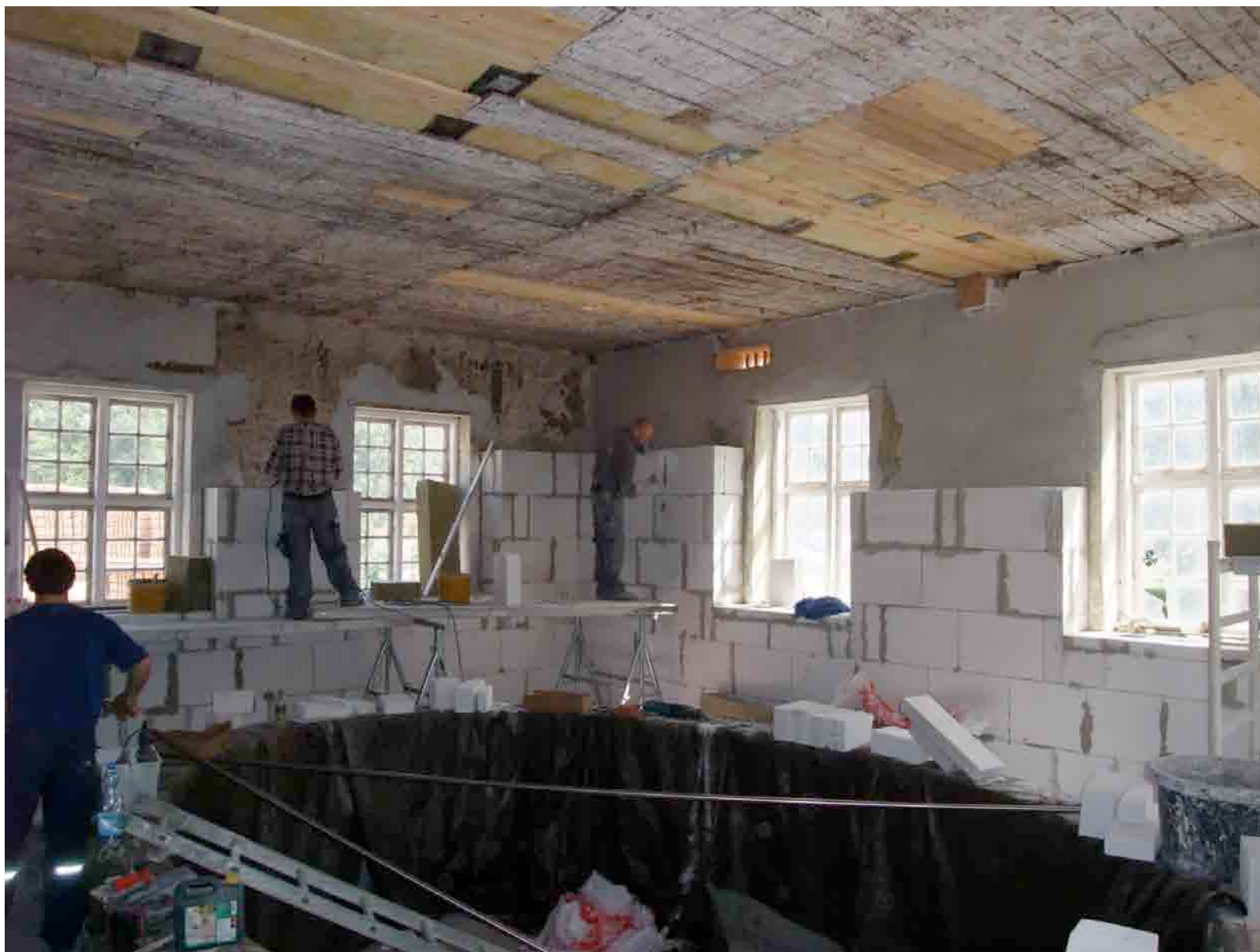
VESTLÆNGEN - UNDER OMBYGNING
