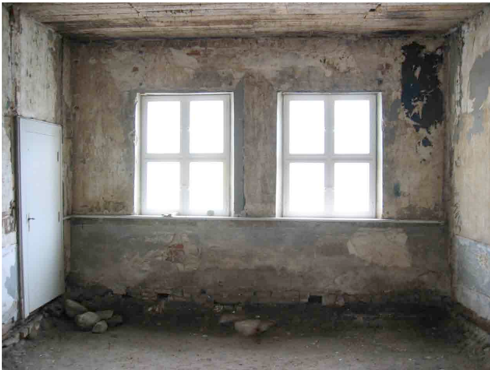
VESTLÆNGEN - UNDER OMBYGNING
