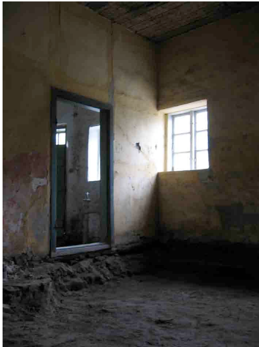
VESTLÆNGEN - UNDER OMBYGNING
