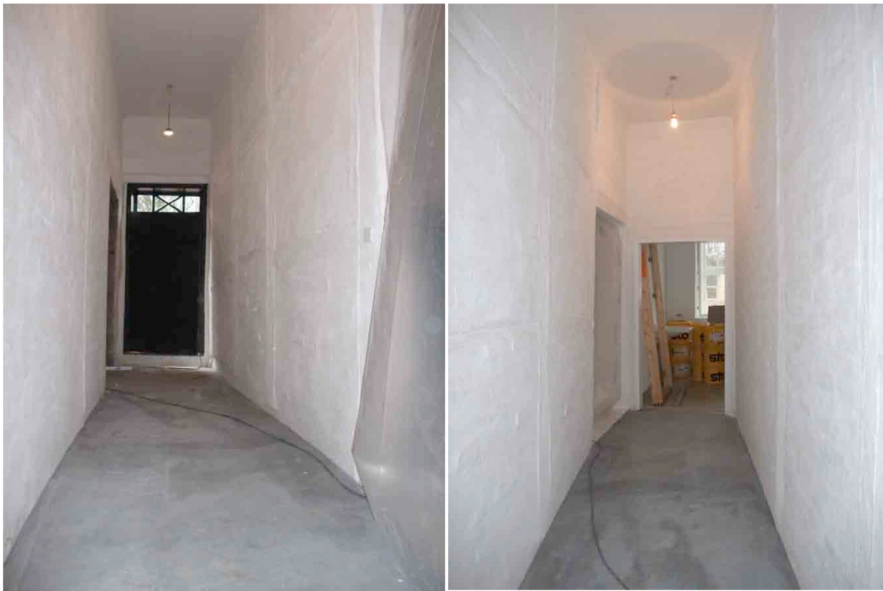
VESTLÆNGEN - UNDER OMBYGNING
