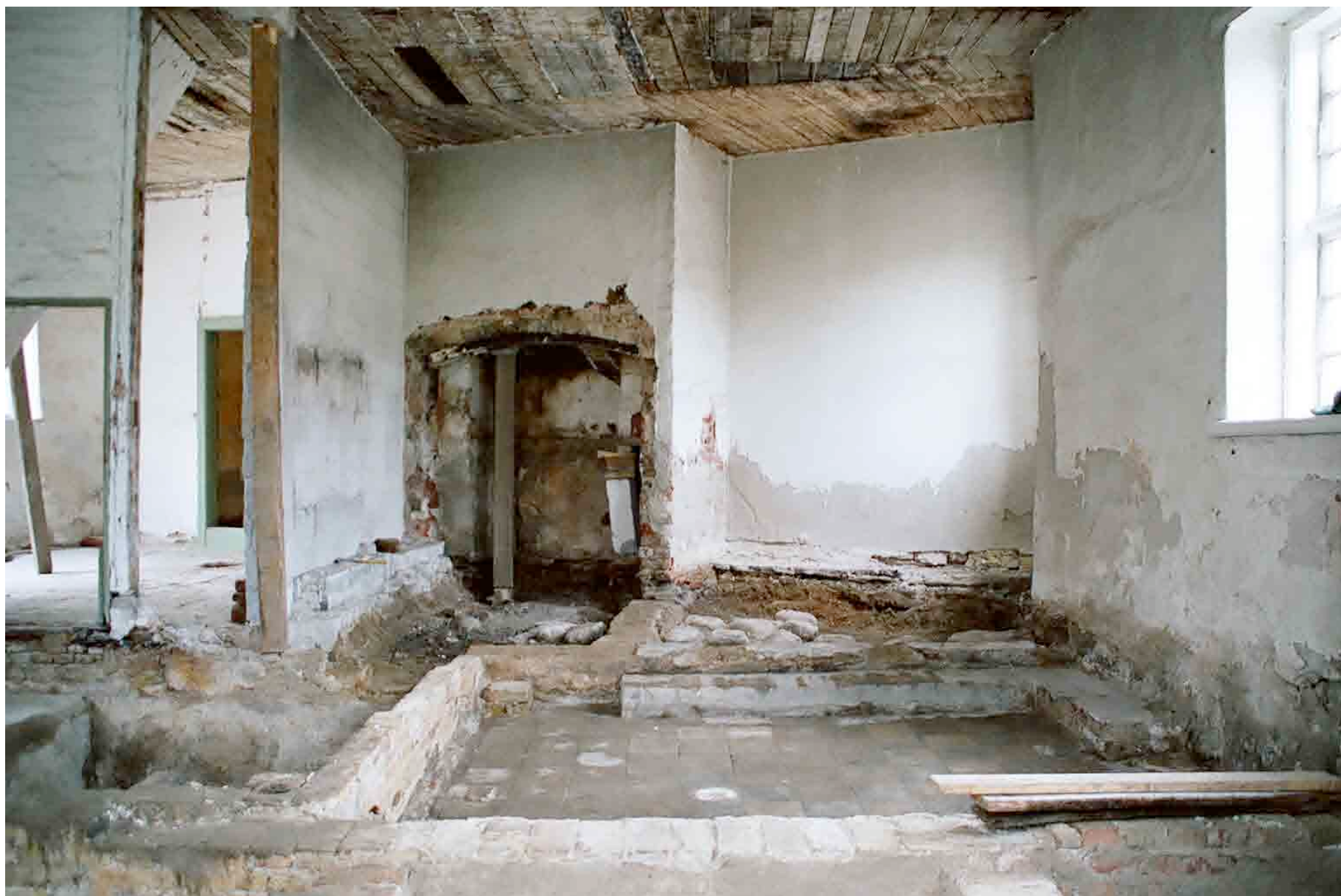
VESTLÆNGEN - UNDER OMBYGNING
