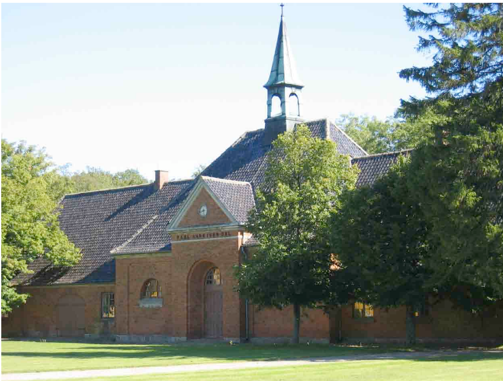
HERSKABSTALDEN - FØR OMBYGNING
