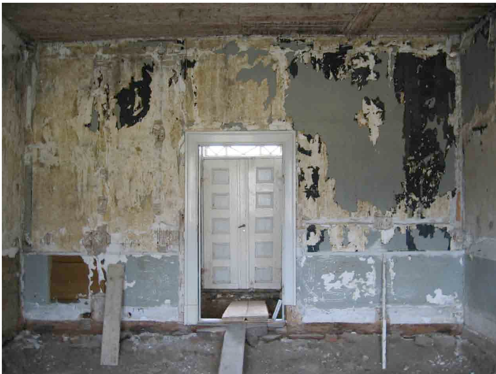
VESTLÆNGEN - UNDER OMBYGNING
